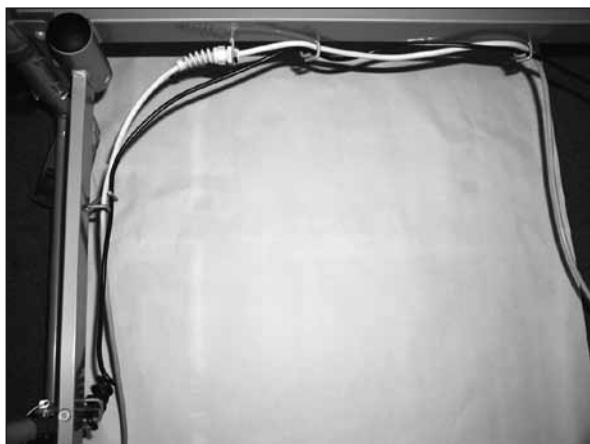
Câblage du moteur du panneau de lit (tête)
